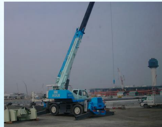
中部国際空港エプロン舗装工事
