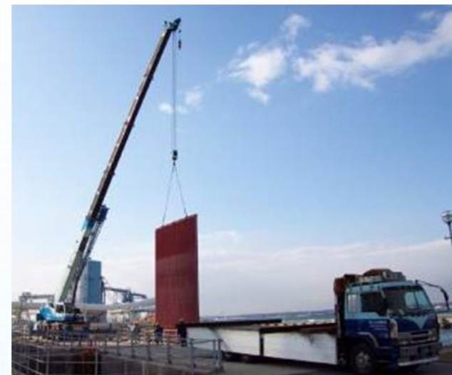
発電所取水口定検工事
