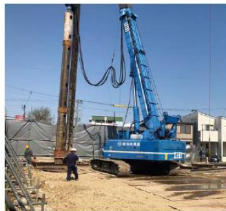
ハイローズコートMS解体工事
