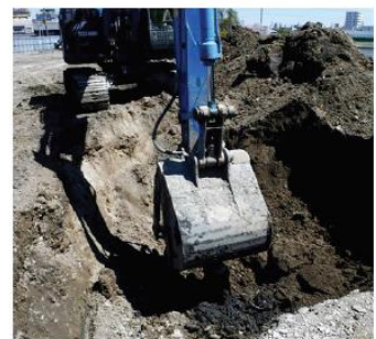
河内ハイツ解体工事
