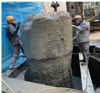
(仮称)吹田市豊津町杭引抜き工事
