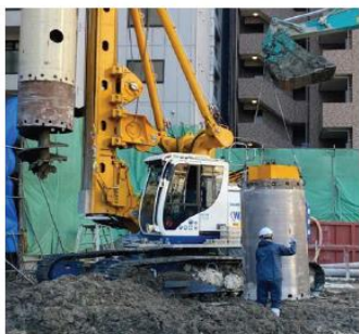
知立杭抜き工事
