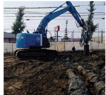
岡崎旧伊藤邸建物解体 杭抜き工事
