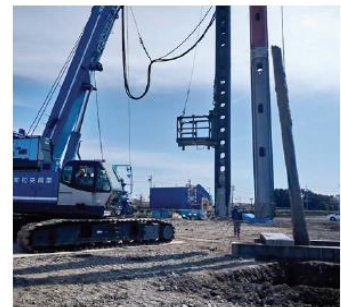
いなべ市A-FLAG大安店 杭抜き工事
