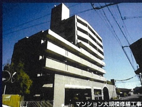
マンション大規模修繕工事
