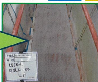
施工箇所(施工後)
