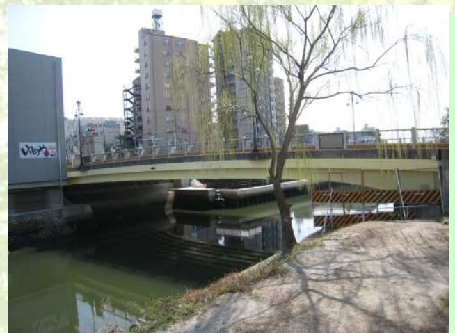
尾頭橋塗装工事
