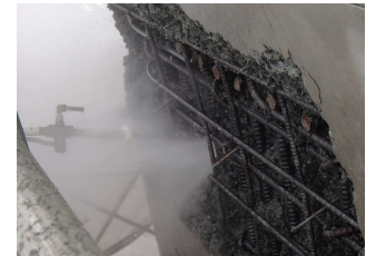
劣化部除去工(WJ研り)
