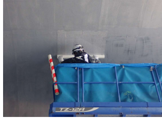
はく落対策工
