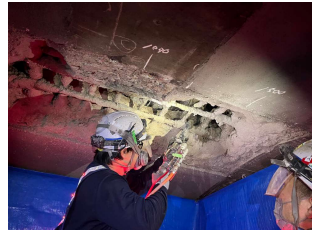
断面修復工(吹付工法)
