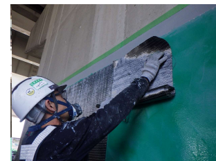
炭素繊維巻立工
