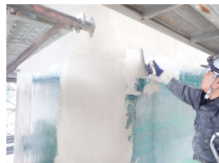
炭素繊維巻立工
