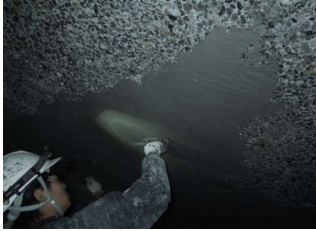
断面修復工(左官工法)
