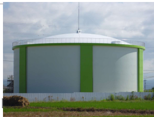
配水池 施工完了
