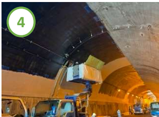
覆工補強工 施工状況
