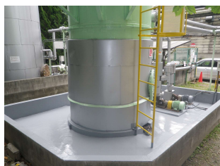
防液堤防 施工完了
