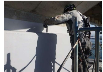
はく落対策工
