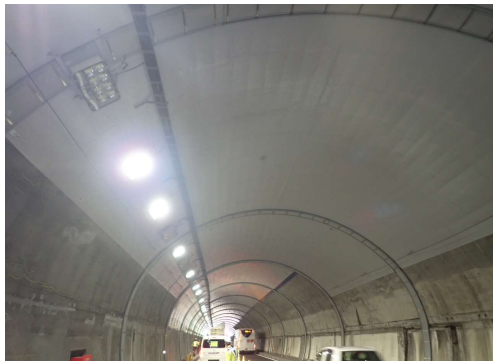
バンドフレキシシ工法 施工中
