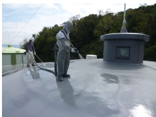
配水池ドーム屋根 防水工
