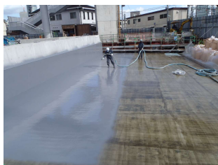
地下構造物 防水工
