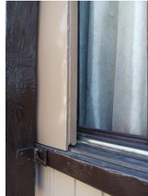
(雨戸ドアの修繕)
