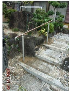
(手すりの取付)
